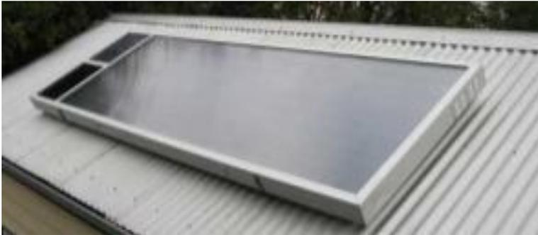
Absorbeur avec ailettes en aluminium, vitrage trempé (PV en option) - Australie
