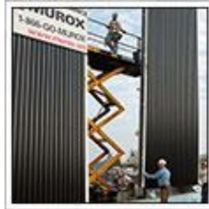
Mur solaire intégré dans murs pré-fabriqués – Canada
