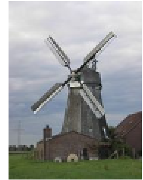
Ailes à système Bilau, Donsbrüggen, Kleve (Allemagne)
