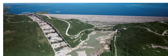
L'aménagement de LG2 comporte un déversoir et deux centrales (Robert-Bourrassa et La Grande-2-A) pour une capacité de 7722 MW.
