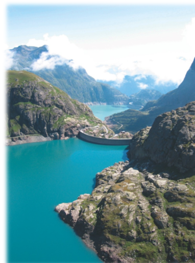
Nant de Drance en Suisse est une centrale équipée de turbines pompes.
