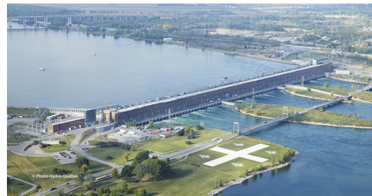
La centrale Beauharnois comporte 26 turbines Francis et 10 turbines hélices. Elle est au fil de l'eau.
