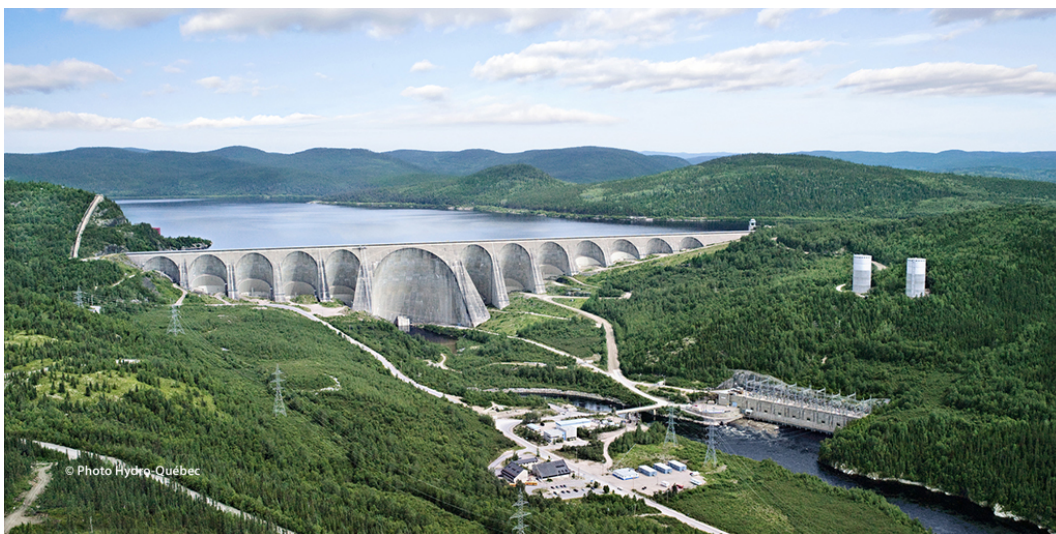
La centrale Manic-5 et le barrage Daniel Johnson sont une icône du développement hydroélectrique
