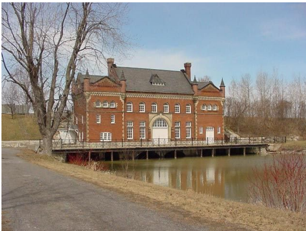
La centrale Les Cèdres en 2009.
