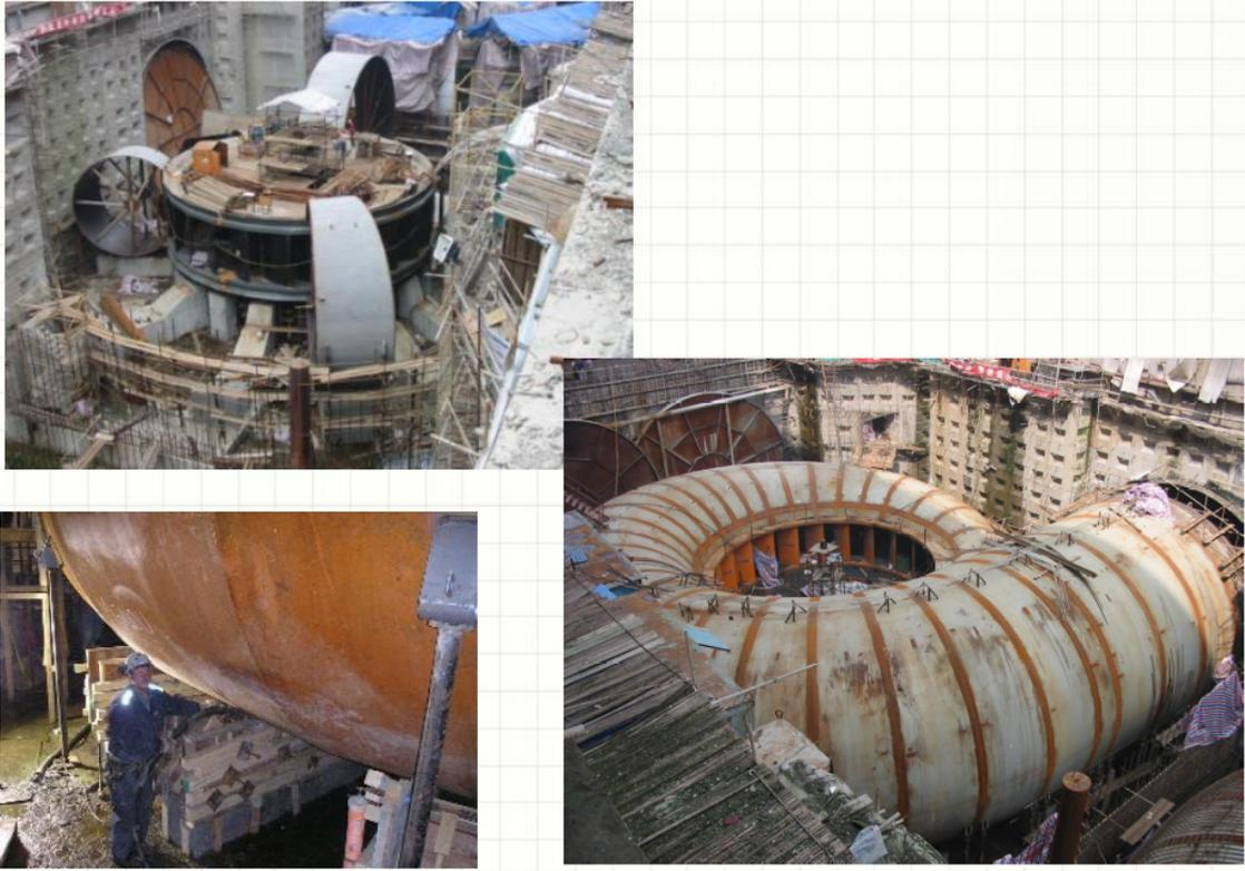
*Sections de bête et berceaux de béton*
