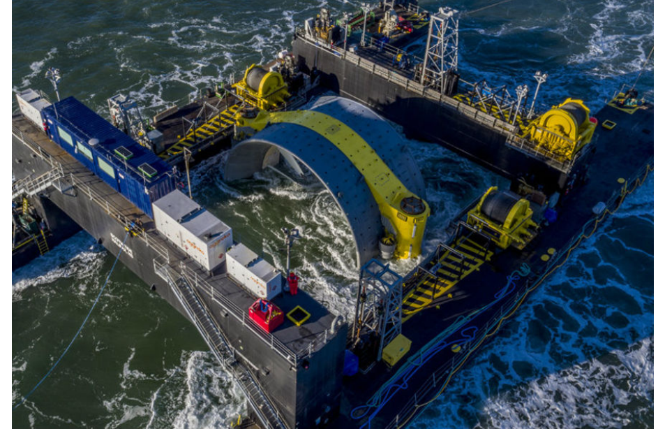
Cape Sharp Tidal, une coentreprise créée par OpenHydro, filiale de DCNS, et Emera, a immergé une première hydrolienne dans la baie de Fundy au Canada, en 2016. 2 MW pour 500 habitants de Nouvelle-Ecosse.
