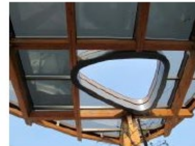
Modules translucides au silicium amorphe (crédit :Nexpower)
