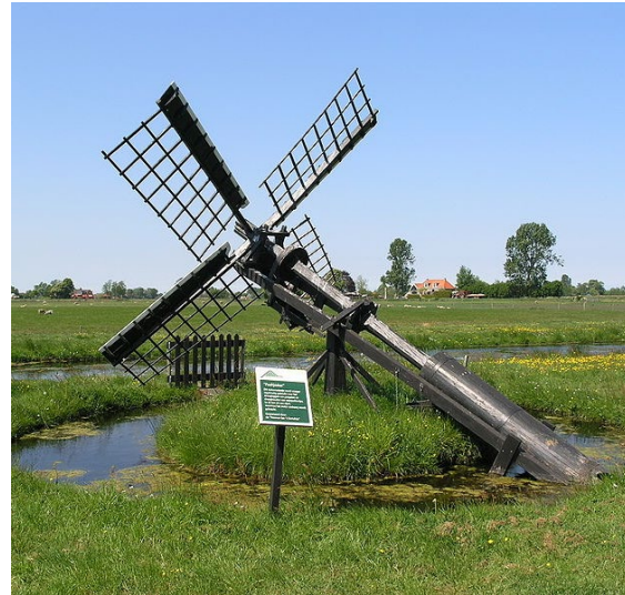
Tjasker – 1600 Pompage de l'eau
