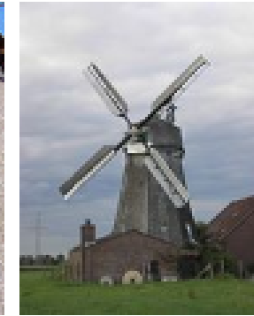
Ailes à système Bilau, Donsbrüggen, Kleve (Allemagne)
