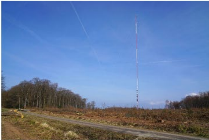
Vue d'ensemble entre Saulnot et Granges-le-Bourg.
