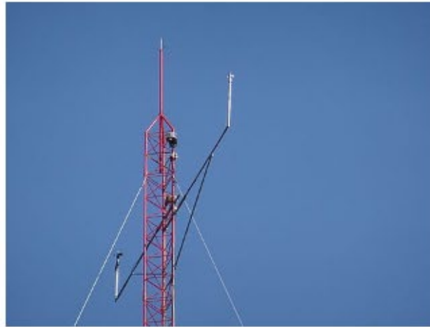
Détail du sommet avec anémomètre, girouette et antenne.
