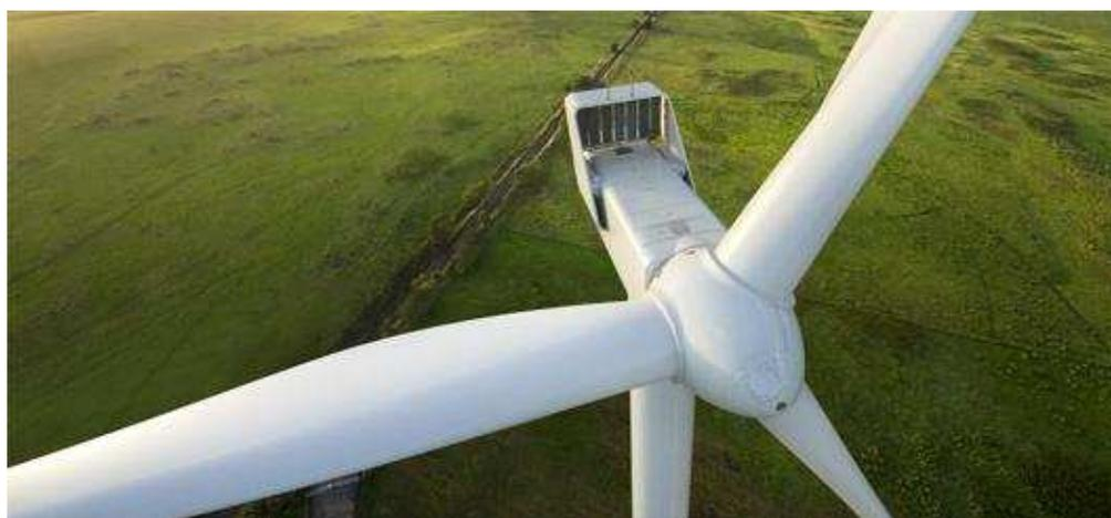
Les pales d'une éolienne « classique » tournent à une vitesse de 5 à 25 tours par minute. (©Courtesy of Vestas Wind Systems A/S)
