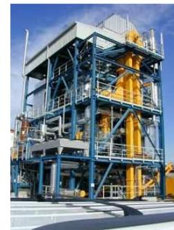
Fig. 4 : Installation de gazéification de biomasse en lit fluidisé circulant de Güssing (Autriche)
