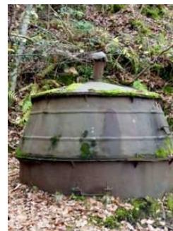
Fig. 1. Ancien four de pyrolyse pour la fabrication du charbon de bois. Source : [http://andre63.canalblog.com/albums/\\_details/photos/59226448-four\\_a\\_charbon\\_de\\_bois\\_a\\_courgoul.html](http://andre63.canalblog.com/albums/_details/photos/59226448-four_a_charbon_de_bois_a_courgoul.html)
