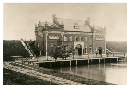
La centrale Les Cèdres en 1910 : classée monument historique en 1984.
