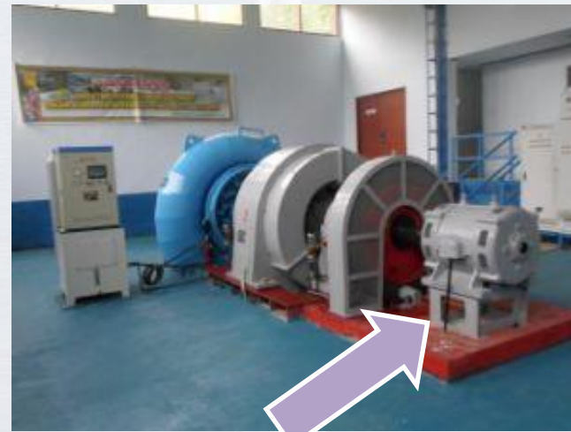
Génératrice C.C. montée sur l'arbre
