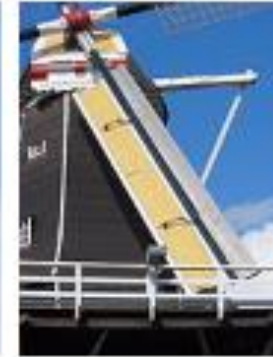
Aile mixte avec bord d'attaque Van Bussel (à droite) et système Ter Have (à gauche), Winterswijk, Pays-Bas.
