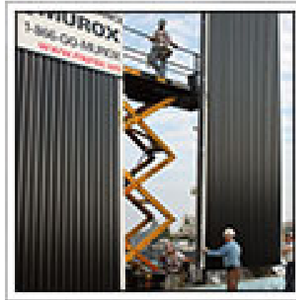
Mur solaire intégré dans murs pré-fabriqués – Canada
