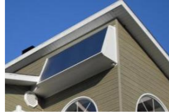
Surface sélective sur absorbeur en cuivre, vitré – assemblage sur site - Canada
