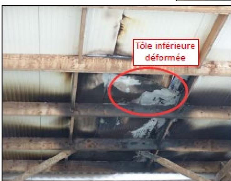
En ouvrant la première peau du bac acier, nous avons découvert une zone très marquée de pyrolyse de la mousse isolante, dans l'axe de l'arc électrique ayant percé l'acier et la zone d'effet thermique du feu du boîtier de raccordement.
