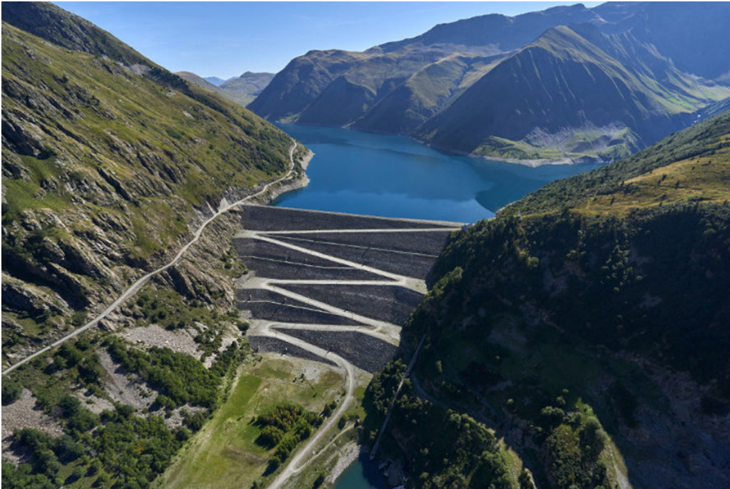
Vue sur le réservoir amont de Grand Maison situé à plus de 900 m au dessus du réservoir aval
