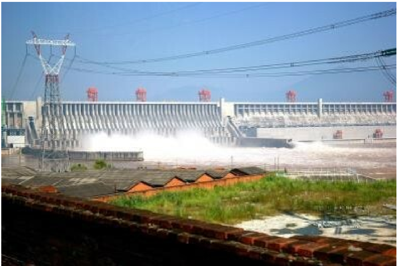
Vue du déversoir et du barrage des Trois Gorges
