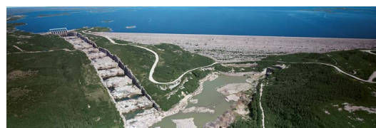
L'aménagement de LG2 comporte un déversoir et deux centrales (Robert-Bourrassa et La Grande-2-A) pour une capacité de 7722 MW.
