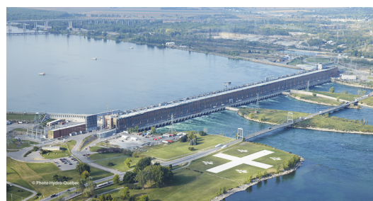
La centrale Beauharnois comporte 26 turbines Francis et 10 turbines hélices. Elle est au fil de l'eau.
