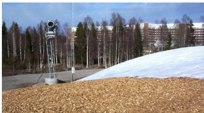
Figure 4 : Vue partielle du réservoir de stockage de froid de l'hôpital de Sundsvall, Suède
