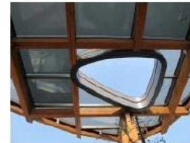
Modules translucides au silicium amorphe (crédit :Nexpower)
