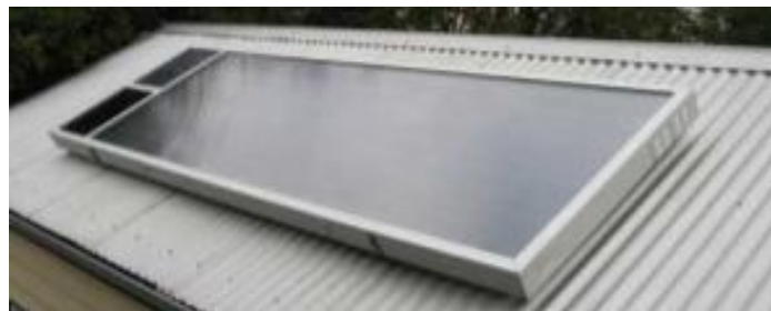
Absorber avec ailettes en aluminium, vitrage trempé (PV en option) - Australie
