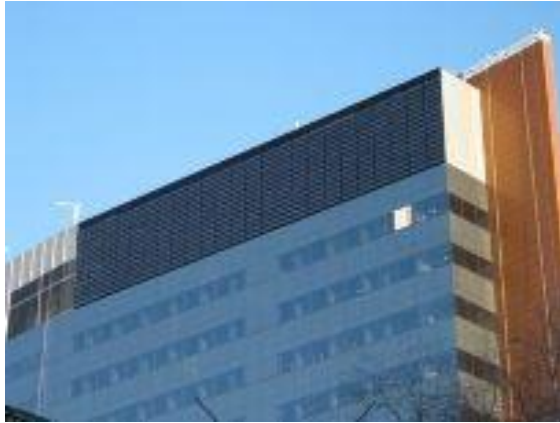
Intégration de PV avec solaire thermique - Canada
