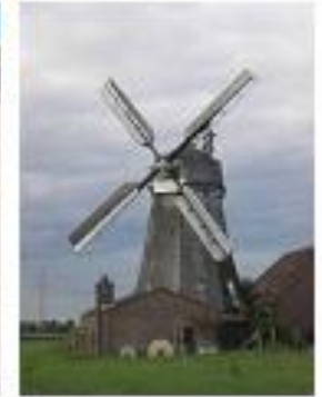
Ailes à système Bilau, Donsbrüggen, Kleve (Allemagne)
