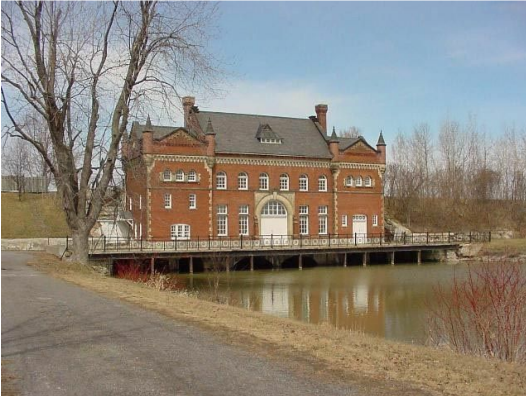
La centrale Les Cèdres en 2009.
