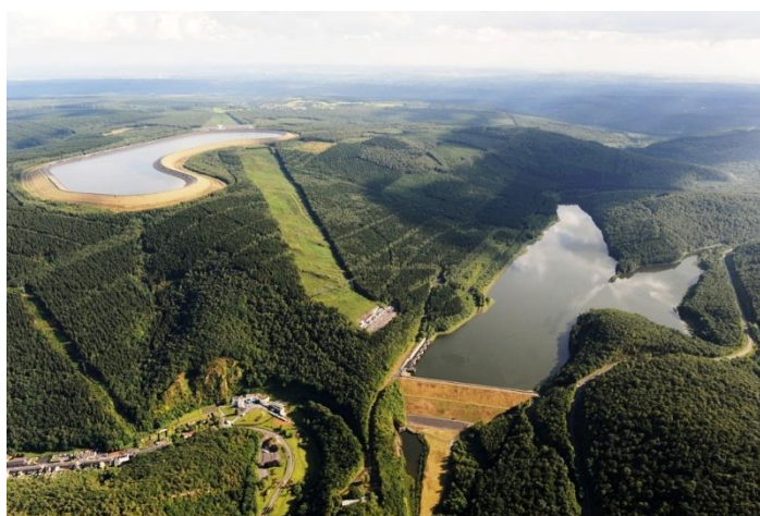
Figure 2 : La STEP de Revin dans les Ardennes, réservoirs de 7 millions de m 3 , dénivelé 230 m (puissance jusqu'à 800 MWh), source [13]
